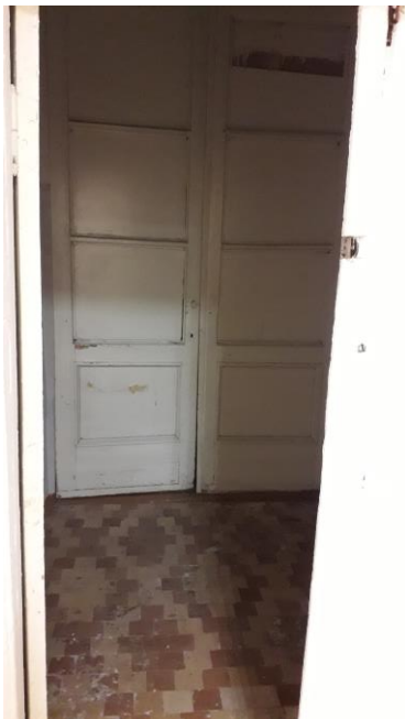
Тамбур входа №5 Фото №13
