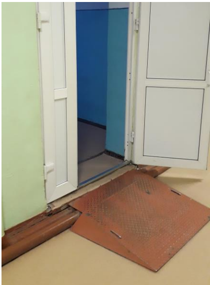
Двери между коридорами 1 этажа Фото №14
