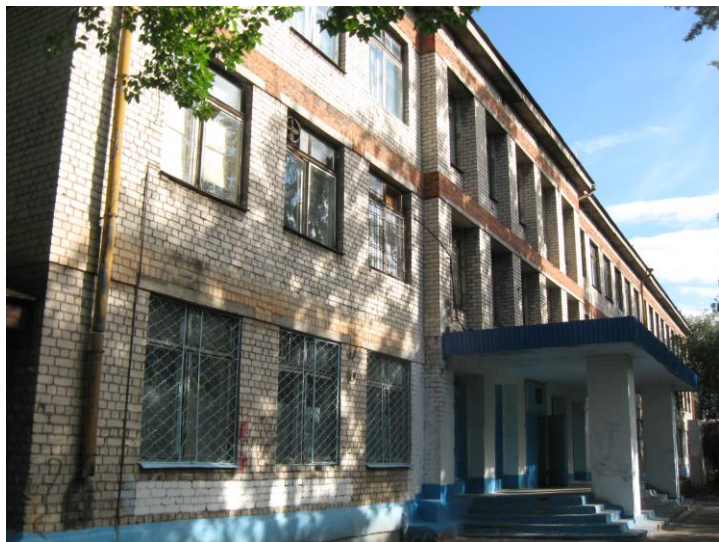
Центральный вход Фото №5
